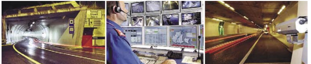
Najvarnejši predor v svetu: Nadzorni sistem v predoru Giswil samodejno odkriva dim in zastoje v prometu.
