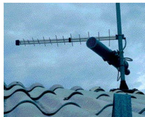
(K)antena na strehi v plastičnem ohišju
